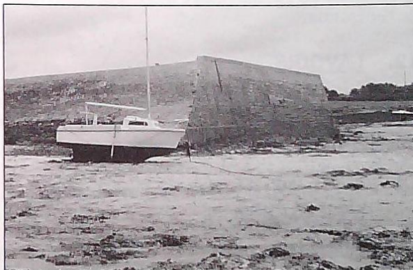
Travaux cale de Port Beni
