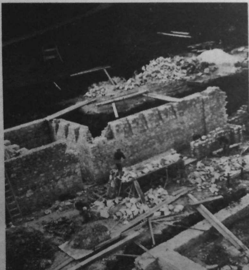
Un aspect du chantier fin novembre
