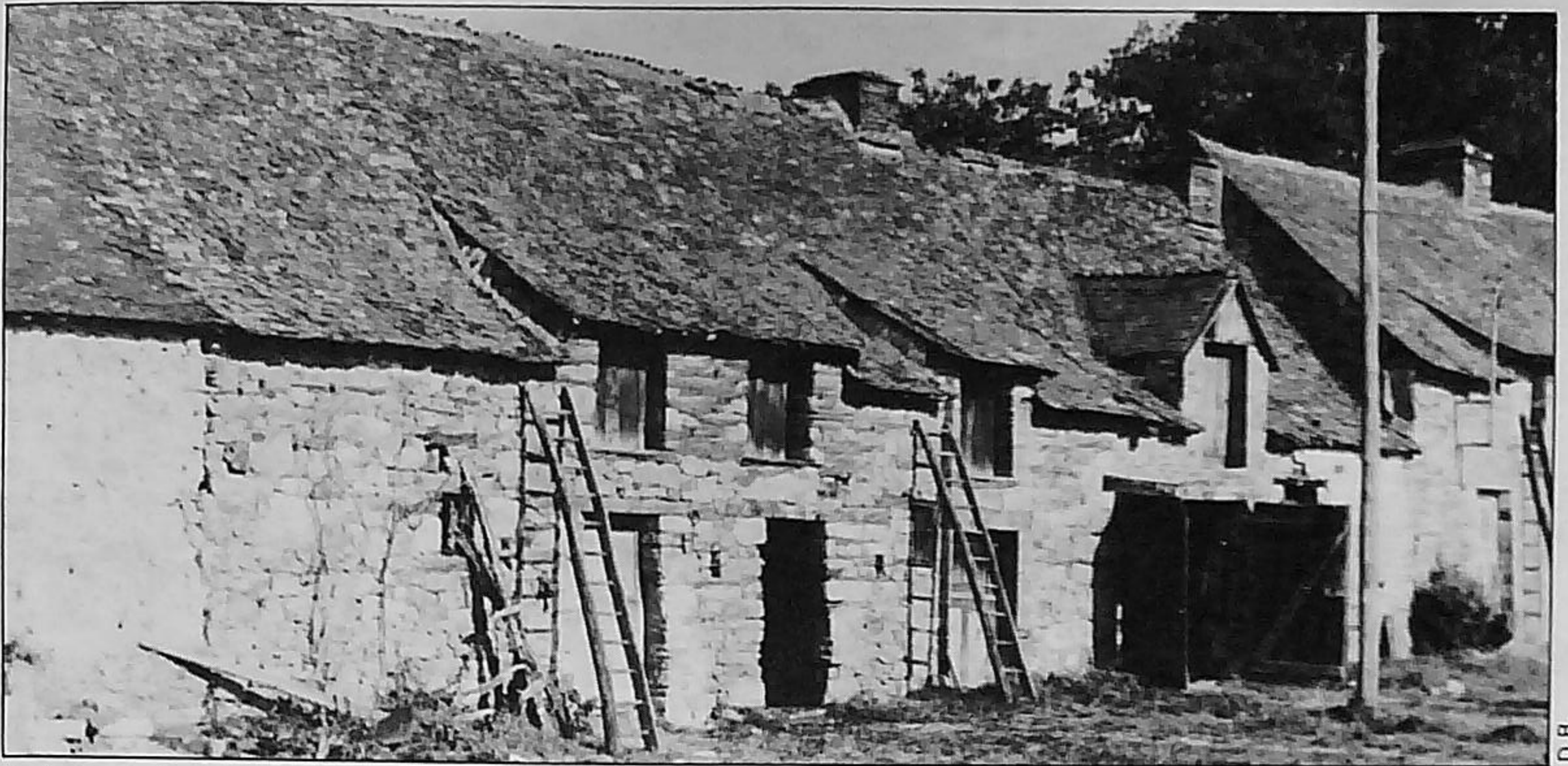
Evolution de la construction au fil des siècles, qui fait que pour les maisons datant de la fin du XVI e , on trouve couramment des murs d'une épaisseur allant de 1 m à 1,50 m, des hauteurs de plafond de 3 à 4 m, des pentes de toiture de 60 degrés. Début XIX e , ces dimensions se trouveront respectivement réduites à 0,50 m, 2,20 m et 80 degrés, comme pour cette maison bâtie à cette époque au Breil, environs de Pipriac.
