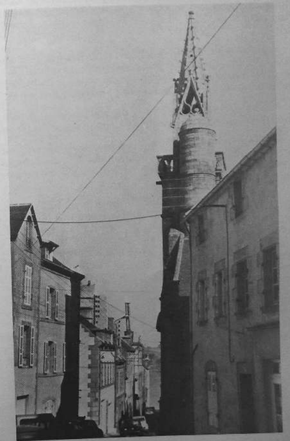
La Fontenelle démolit les fortifications de Douarnenez pour élever celles de l'île Tristan. La tradition veut qu'il ait rasé la ville mais épargné cette chapelle Sainte-Hélène de style gothique flamboyant.
