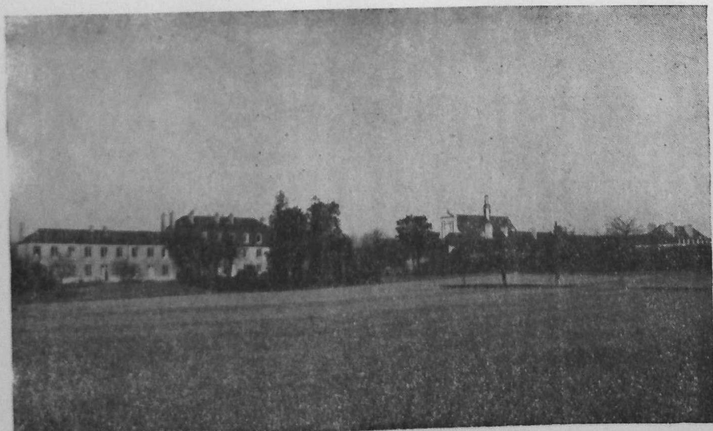
La Chartreuse d'Auray. — Vue d'ensemble en 1949. Habitation des Frères. — Résidence des Pères Aumôniers. — Communauté des Sœurs. — Institution.
