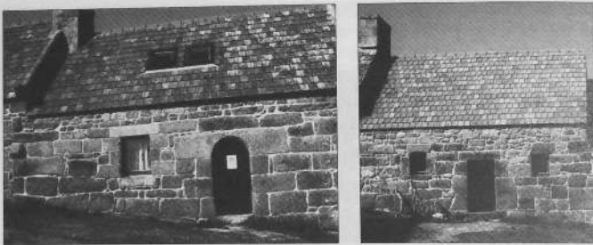
Fig. 13 - Façades Est des bâtiments C et D.
