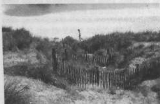
Six ans après le début des travaux, le couloir d'érosion Nord est en bonne voie de cicatrisation.
