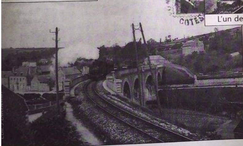
Viaduc de Pontrieux
