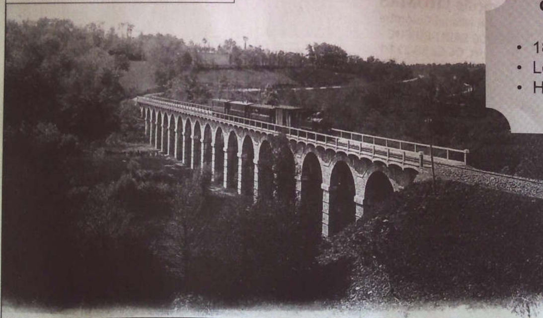
Viaduc de Blanchardeau
