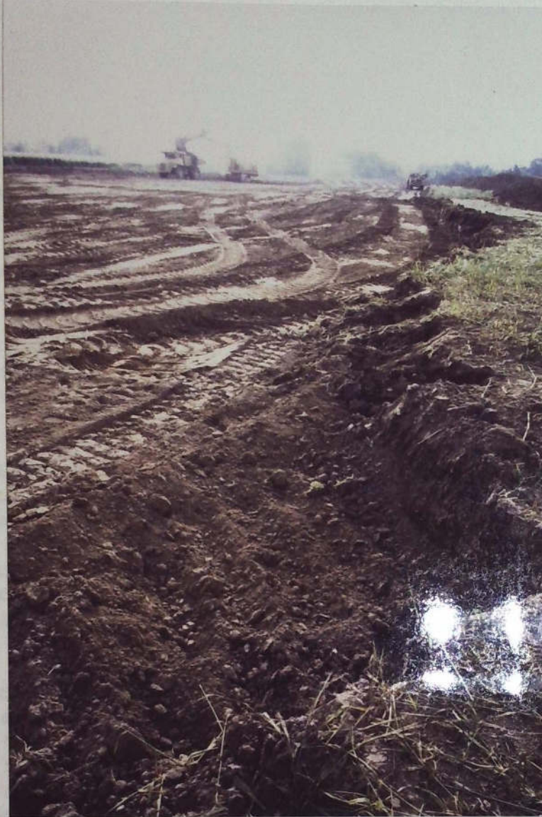
Photo n° 2 : vue des décapages de terre végétale
