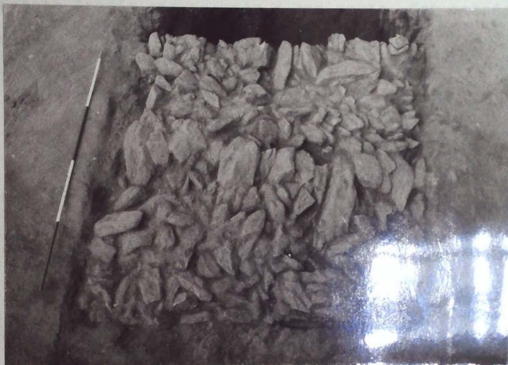
photo n° 25 : remblais appuyés sur des murs de soutènement successifs, destinés à permettre l'élargissement de la porte piétonne de phase 1.
