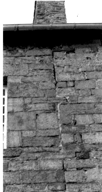
Troisième rupture de maçonnerie (ci-contre) et... encore une autre près du presbytère (ci-dessus).
