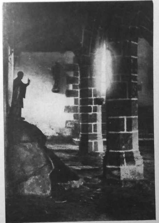
FONTAINE DE SAINT-ÉDERN. Surmontée de la statue du Saint, dans la Chapelle de Coat-ar-Roch, près de Lannédern (Finistère). Cliché Hamonic.
