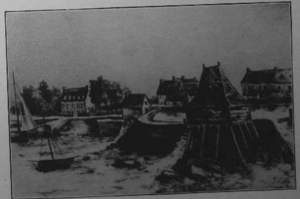
Fig. 7. — LA CHAUSSÉE DES MOULINS Avant la construction du premier bassin.
