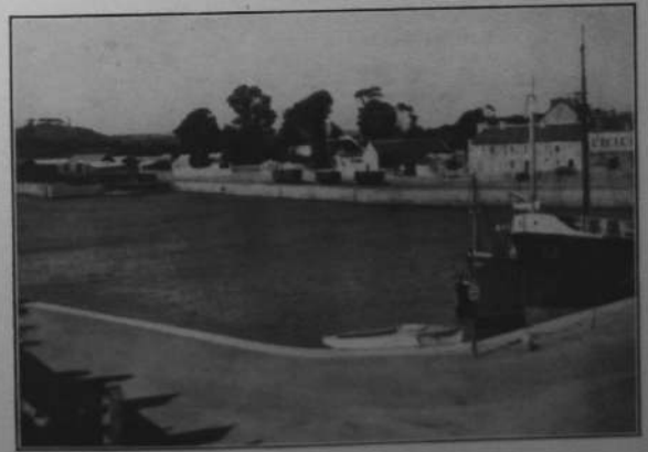
FIG. 20. — PAIMPOL LA MORTE... On ressent autour des bassins vides et des quais déserts l'impression d'une absence.
