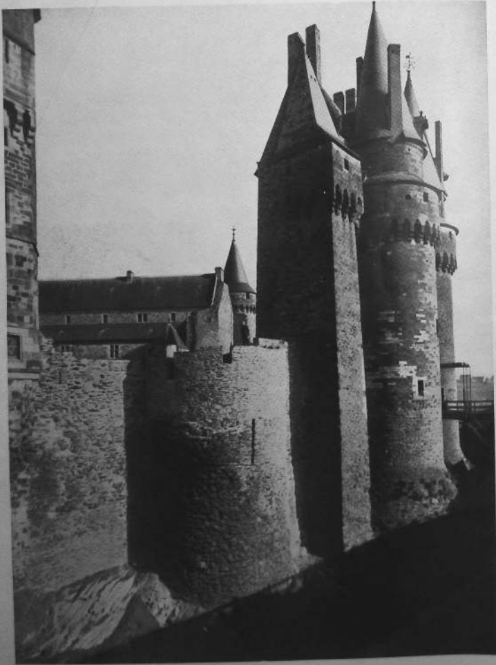
La tour d'entrée et le pont-levis.
