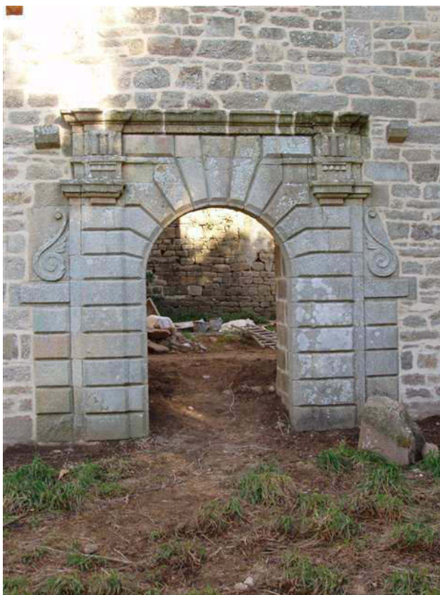
Coatmalouen : porte ouvrant du cloître sur l'abbatiale
