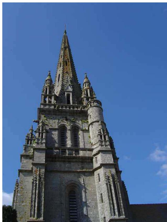
Les quatre clochetons disposés au coin de la plateforme de la tour sont ancrés à la flèche par deux corbeaux. L'eau de ruissellement est évacuée par 8 gargouilles sous forme de corps d'animaux extravagants (ces gargouilles sous cette forme sont là pour exorciser le mal, le péché...).
