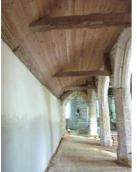
Quatre piliers supportent des arcs brisés qui permettent l'ouverture de la nef sur le bas-côté. Les trois premiers reposent sur une base hexagonale et les voussures de l'arc se confondent dans le pilier. Par contre le quatrième, mérite quelque attention : en effet, cylindrique et à hauteur d'homme, il est ceint d'un cordon. Les arcs brisés reposent sur un chapiteau également cylindrique mais sur le bas-côté il est orné d'une agrafe.
