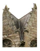
Les trois baies vitrées sont constituées de deux lancettes surmontées de deux soufflets (*en forme de fer de lance*) et une variante de mouchette<sup>6</sup>, le tout calé par deux écoinçons. Les quatre contreforts, au droit des noues, supportent quatre gargouilles extravagantes :
