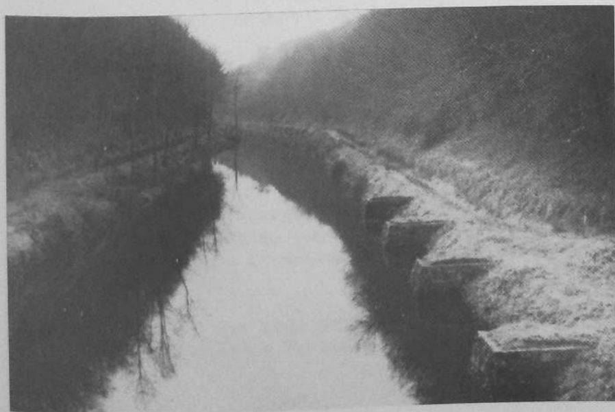
GLOMEL La tranchée vue de la passerelle vers BREST
