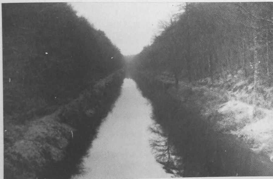
GLOMEL La tranchée vue de la passerelle vers NANTES
