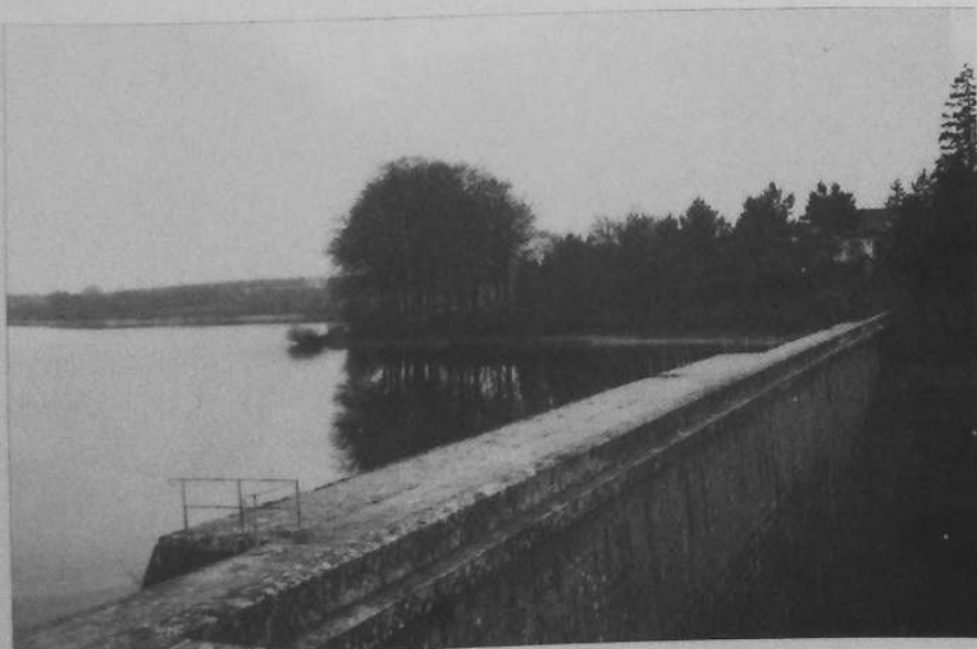
GLOMEL Barrage de CORONCQ
