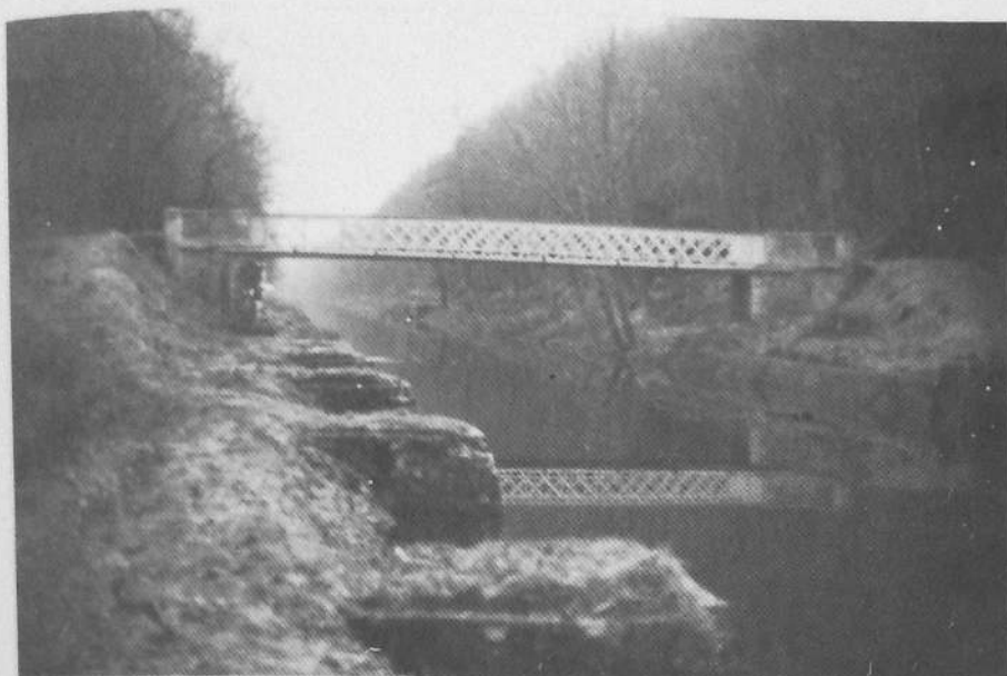
GLOMEL Au coeur de la tranchée, la passerelle
