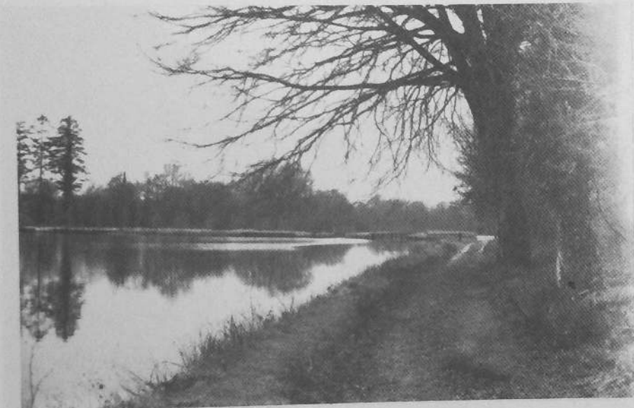
GLOMEL Sortie Ouest de la tranchée
