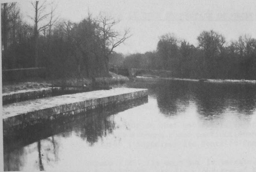
Ecluse de ST PERAN Regard vers l'entrée ouest de la tranchée
