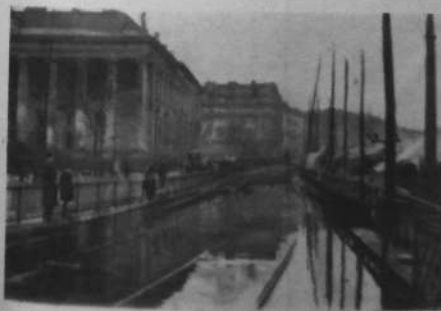
Nantes. — Entre le Palais du Commerce et la gare de la Bourse les trains ont circulé dans l'eau, affleurant les rails.
