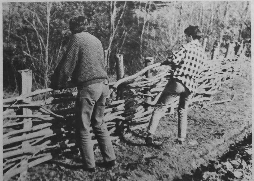
Construction d'une palissade par des élèves du Lycée Agricole de Pontivy.
