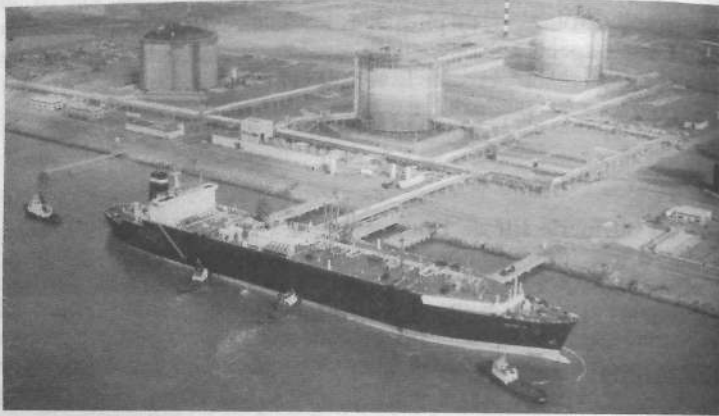
Le terminal méthanier de Montoir de Bretagne en Loire-Atlantique.
