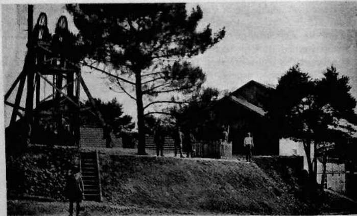
FIG. 11. — Mines de wolfram de Montbelleux. — Le puits Collet.
