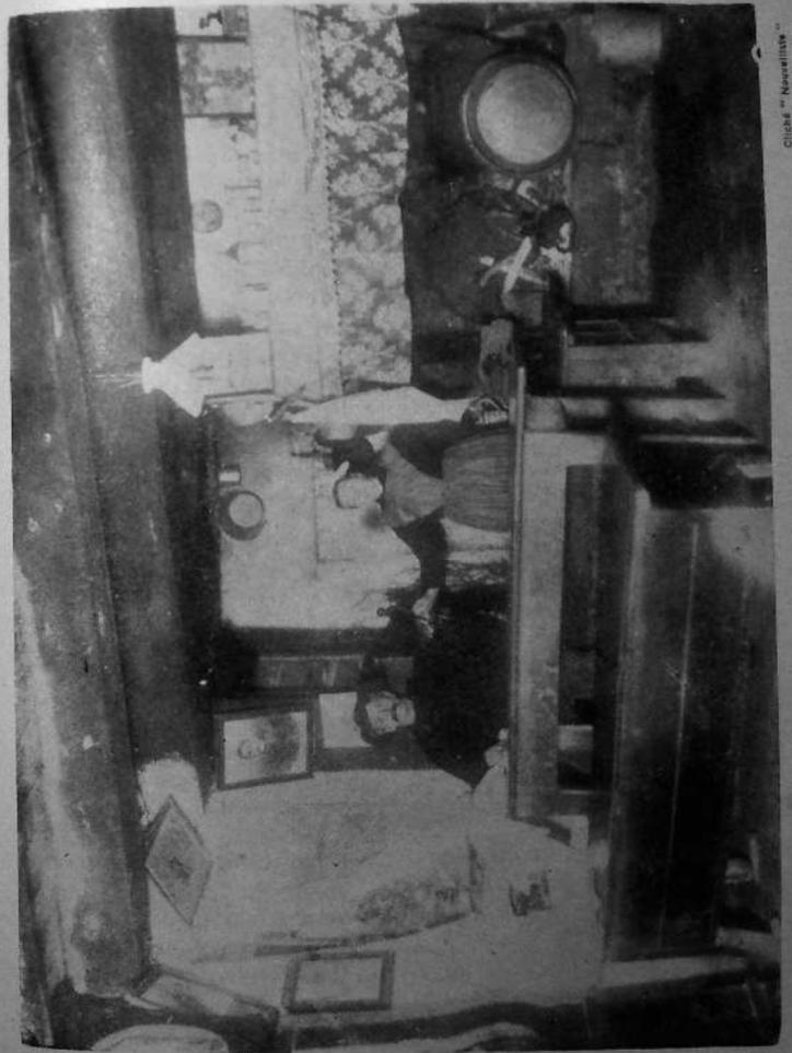
Le sol y est en terre battue, rarement dallée ; le plafond est constitué par le plancher du grenier, à poutres et solives apparentes. Les murs sont généralement blanchis à la chaux ou recouverts d'un badigeon ocré.
