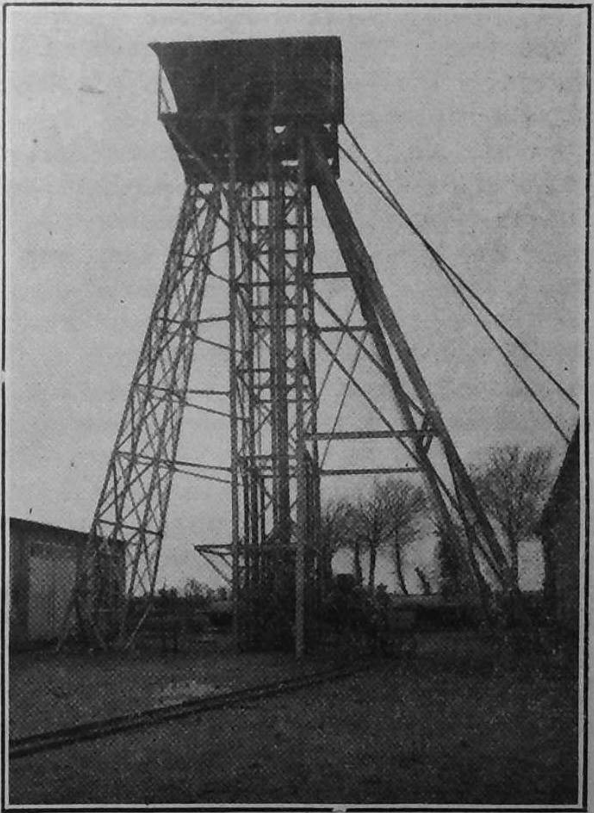
Mine du Huelgoat. — Puits de Poullaba.
