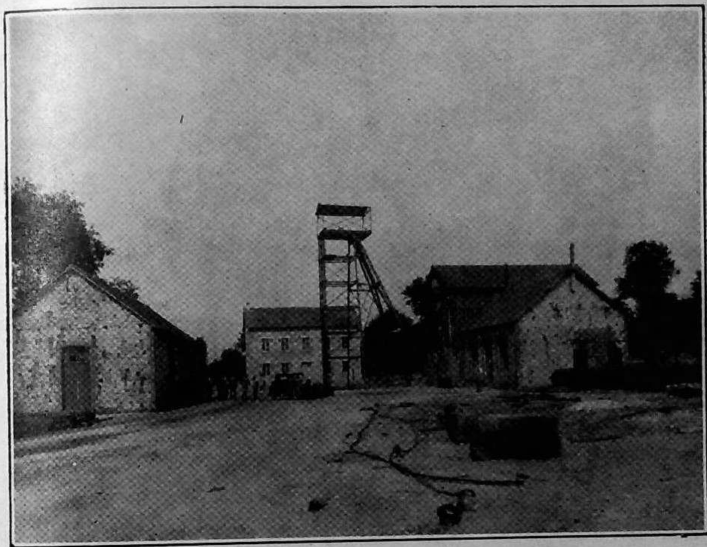
Mine de la Touche. — Chevalement en construction.
