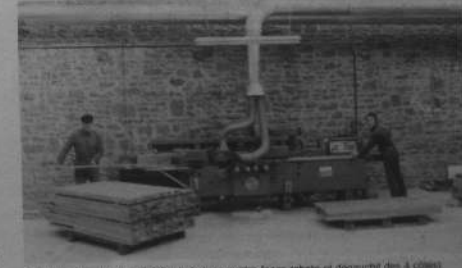
St-Hilaire-des-Landes. L'atelier bois (une quatre-faces rabote et dégauché des 4 côtés).
