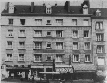
Le premier immeuble construit dans le boulevard Leclerc (1949). (Une des « 3 casernes »)
