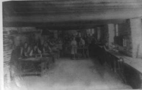
L'atelier de travail manuel destiné aux « enseignements spéciaux », installé dans le sous-sol du collège (coll. Mme Audran)
