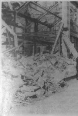
C'est ce qu'il reste de l'usine Cordier
