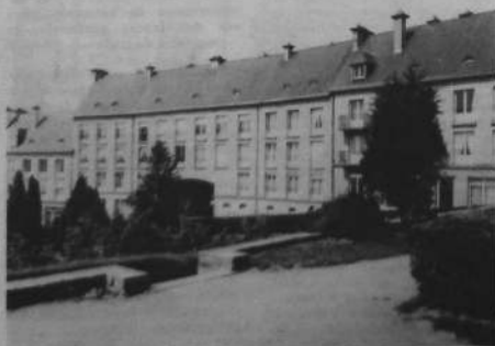
Les immeubles reconstruits de la rue de la Pinterie vus des jardins sur les remparts.
