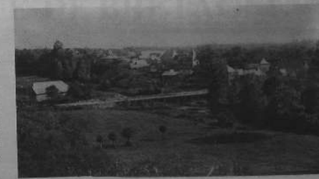
Vue générale d'Ohis entre les deux guerres, avec l'un des ponts sur l'Oise reconstruit
