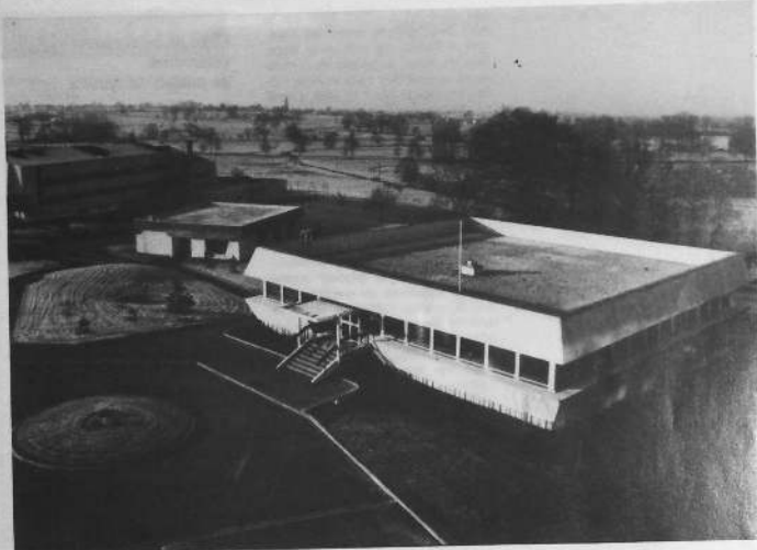
Vue d'ensemble des installations du Laboratoire.
