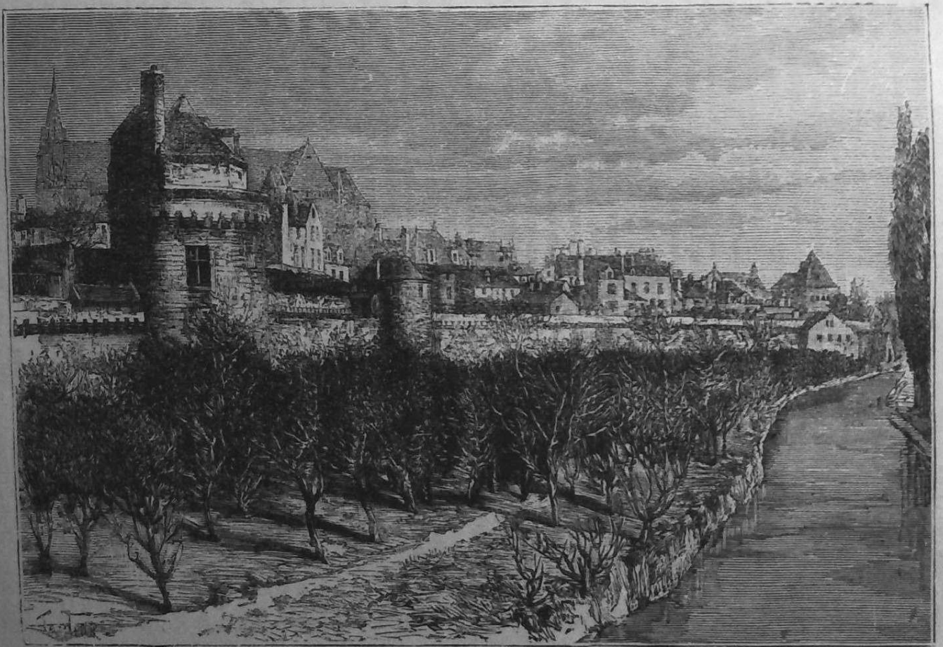
Anciennes murailles de Vannes.
