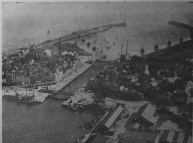
L'entrée du port de Saint-Nazaire. Au centre : la forme-écluse.
