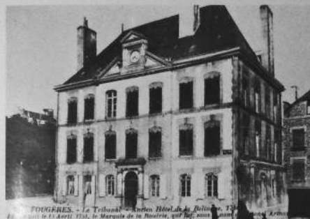
FOUGÈRES. - Le Tribunal - ancien Hôtel de la Belinaye. Travaux de reconstruction de la façade et aisé de Washington.
