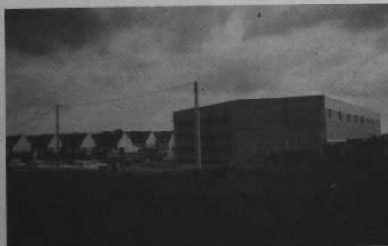
Le complexe sportif en construction, près du lotissement.
