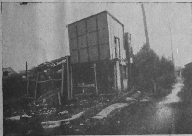
On a réparé la baraque comme on a pu, mais... gare aux prochaines averses!...
