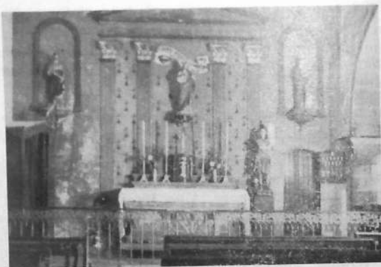
EGLISE : COTÉ BAPTISTÈRE AVANT RESTAURATION.
