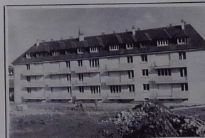
RÉSIDENCE SAINT-ROCH Premier bâtiment terminé
