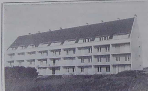
RÉSIDENCE DU BELVÉDÈRE Premier bâtiment terminé
