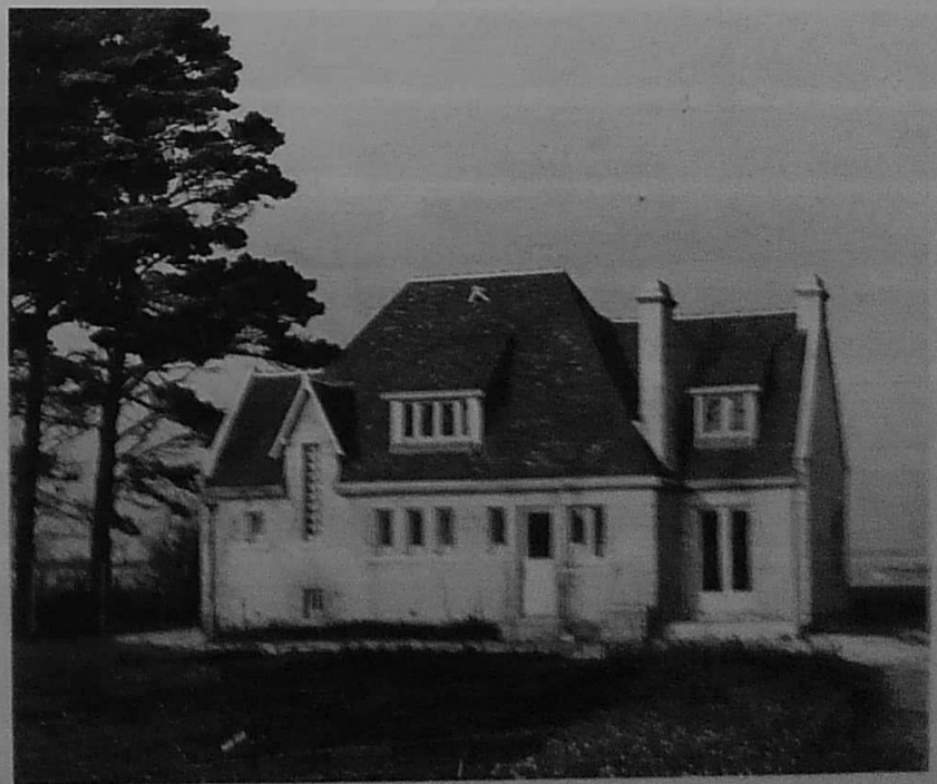
VILLA A LOCTUDY. - E. LE GUELLEC, ARCHITECTE A QUIMPER.
