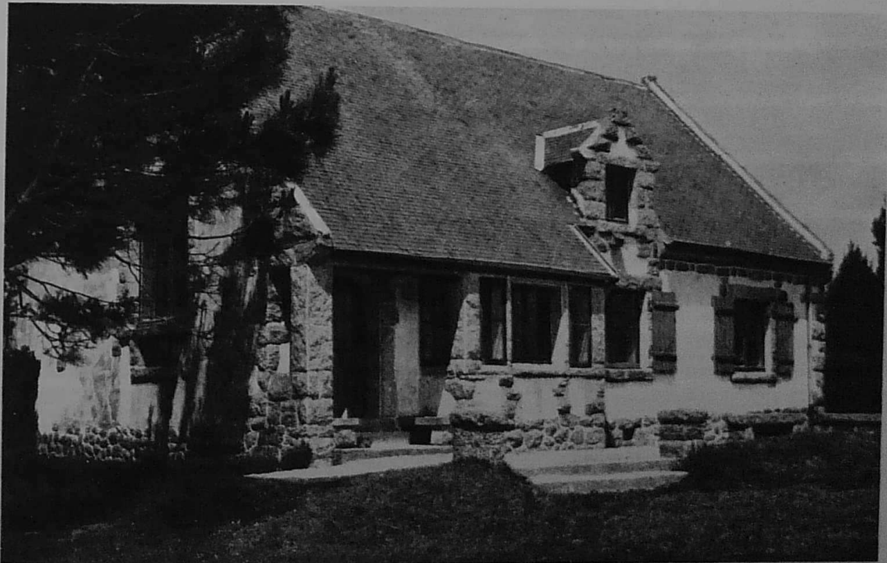
VILLA A LANRIEC. - ROBERT DESOUCHES, ARCHITECTE A LORIENT
