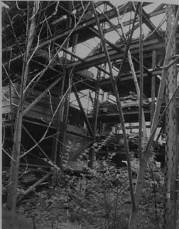
Les bâtiments de la friche vont être affectés à d'autres fonctions.
