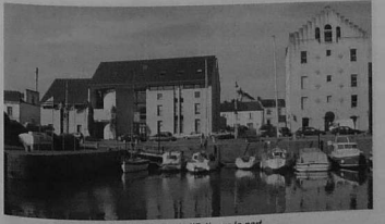
Le bâtiment de l'ESLI, sur le port.
