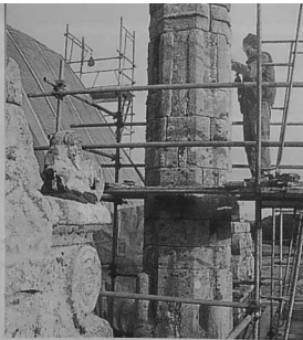
Un vaste chantier est engagé à l'Abbaye de Beauport (Ph. SRA JP Barde/AGRAB Beauport).
