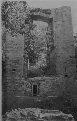
Le site du château de Rieux subit actuellement une consolidation de son pilier central.
