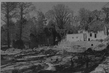
Le site de la mine de la Villeder au Roc Saint-André (photo C. Rio, Ploërmel).
