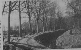
Le moulin du Prat, tel qu'il apparaissait avant la restauration de la digue, celle-ci ayant été réalisée au cours de l'automne dernier.
