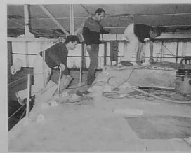
Pen Duick V renaviguera prochainement. Il est équipé de ballast, système performant conçu par Eric Tabarly. Le chantier se termine en septembre, mais le bateau ne retrouvera sa quille d'origine qu'ultérieurement.
