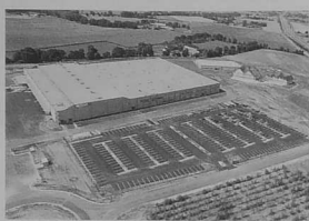
Une usine toute neuve pour le groupe japonais Sanden, à Tinténiaac, 300 emplois dans deux ans sur le marché des compresseurs de climatisation automobile.
