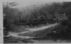
Le Moulin-neuf à St-Clet - au Ter plan, la passe à poisson qui a été aménagée. (Photo Gilles Huët).
