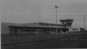
La nouvelle aérogare sera bientôt mise en service.
