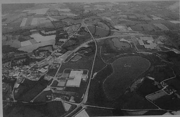
Kermené vu du ciel : à gauche le bourg de Collinée et le bâtiment initial Kermené 1, à droite vers le centre Kermené 2 ; au centre la réserve d'eau puisée l'hiver dans la Rance qui prend sa source à proximité ; juste au-dessus Kermené 3 et les locaux administratifs près de l'étang plus petit. (Photo Kermené).
