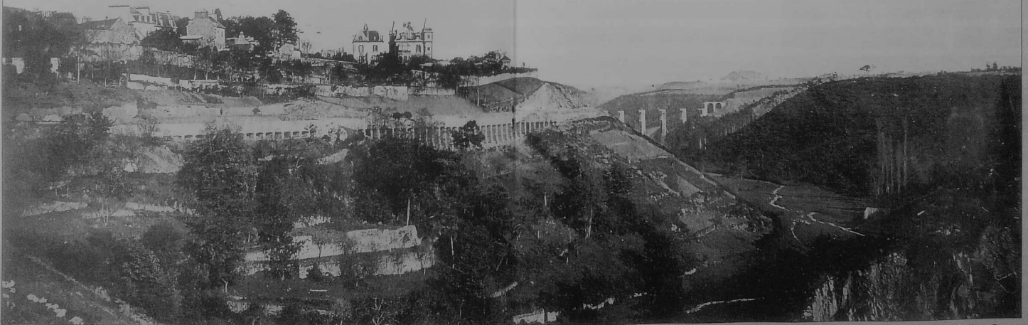
Juillet 1903 : les murs de soutènement du boulevard Sévigné sont en voie d'achèvement. Au second plan, les 2 châteaux démolis en 1936 pour la construction du Collège Renan. Au fond, le viaduc. : les piles centrales et les 2 arches Sud sont achevées. (Collection FT).
