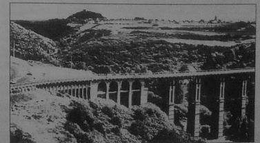
1963 : vue de la partie Nord de l'ouvrage. Le carrefour est aménagé. (Collection MH).
