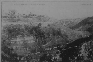
Printemps 1904 : vue générale de la vallée. Le tablier est en cours de réalisation sur les 7 arches métalliques. (Collection FT).
