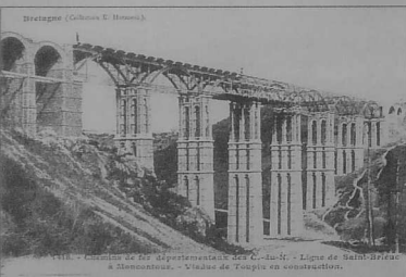
Début 1904 : le tablier est en cours de réalisation sur 2 arches et demie. (Collection AL).
