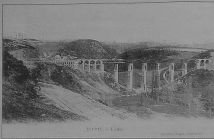
Fin 1903 : les 7 arcs métalliques sont en place. Le tablier est en cours de réalisations sur une arche et demie. (Collection Y B).
