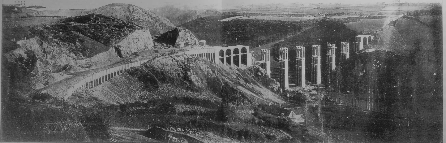
Juillet 1903 : sont achevées : les 4 arches Nord, les 6 piles centrales et les 2 arches Sud. (Collection FT).
