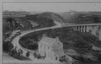
Vue prise du cimetière de Saint-Michel : le petit train, à l'arrière-plan, l'embranchement vers plouha et le viaduc. La maison existe toujours. (Collection FL).
