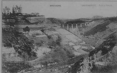
Même stade de travaux : vue générale. (Collection FT).
