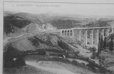
Juin 1904 : le garde-corps est en cours de pose sur les travées centrales. (Collection FT).
