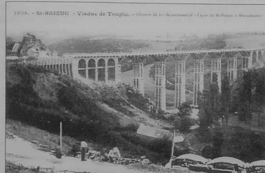
Juillet 1904 : le garde-corps est entièrement posé sur le viaduc. Au premier plan, réalisation du mur de soutènement boulevard Sévigné, à hauteur du moulin de Toupin. (collection YB)
