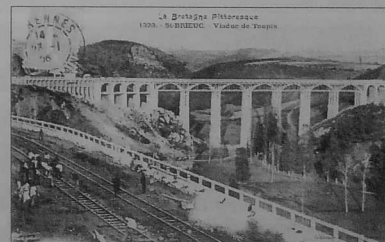
Septembre 1904 : réalisation des travaux de pose des lignes de voies ferrées ; les parapets sont posés au-dessus des murs de soutènements. (Collection FT)
