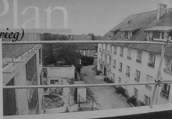
En face de l'ancien bâtiment, la nouvelle structure prend forme.
