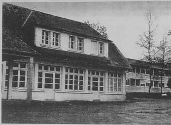
L'ancienne maison de retraite de Kérampuil va être rénovée, aux frais de la communauté de communes du Poher, pour accueillir l'internat du lycée Diwan. Les salles de classes seront construites à proximité.
