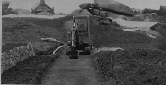
La troisième tranche (photo lors des travaux) est aujourd'hui achevée.
