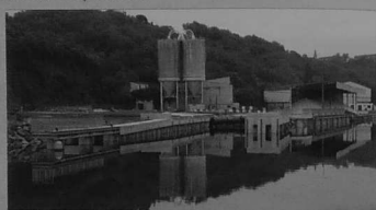
La plateforme, en construction au Légué.
