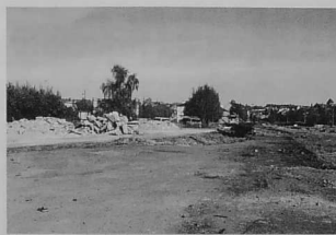
L'espace de la gare va subir de profondes transformations.
