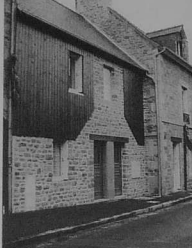
An Bourg de Parigné, une ancienne maison réhabilitée en 4 petits logements.
