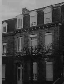
Opération de réhabilitation à Saint-Brieuc d'une copropriété de HLM.
