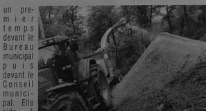
Pour alimenter les chaudières en bois des collectivités, une filière est en place.
