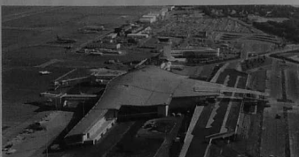
La nouvelle aérogare donne de belles perspectives de développement à Brest.
