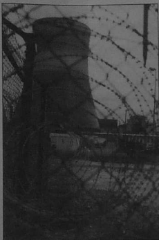
Les effets pervers de l'électricité nucléaire.
