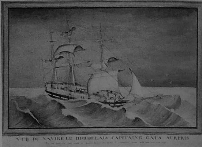
Le « Bordelais » en difficulté au Cap-Horn
