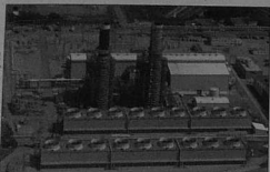
Une centrale gaz à cycle combiné en Allemagne.
