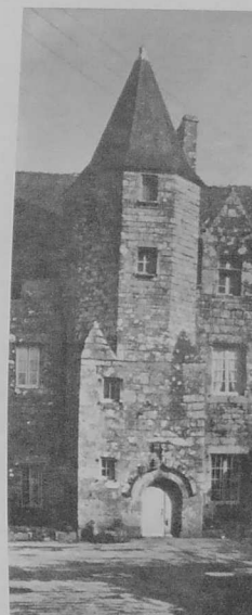
Pl. 8 — Fournebello la tour d'escalier
